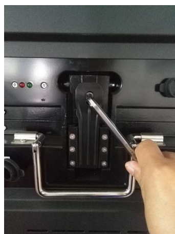
上下相邻箱体之间用锁扣锁紧 用 M6 内六角扳手将螺钉锁紧 图 14. 箱体安装图
